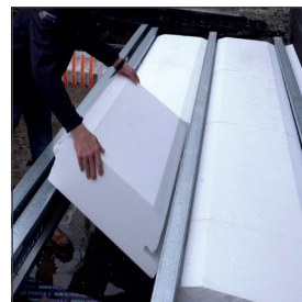
EPS broodjes plaatsen
