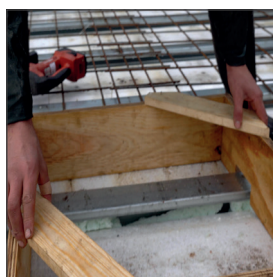
Bekisting / wapening plaatsen
