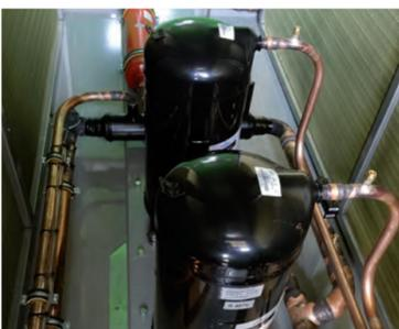
Courant de démarrage faible travers plusieurs compresseurs Scroll – efficaces et silencieux !
