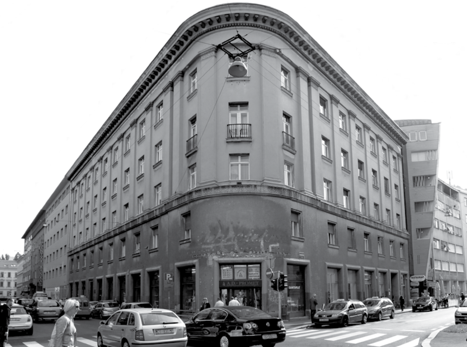
Zgrada na uglu Amruševe i Petrinjske, nekadašnje sjedište Nadrabinata, jedan od najvrednijih do sada vraćenih objekata
