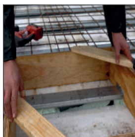
Bekisting / wapening plaatsen
