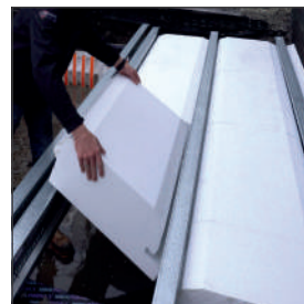
EPS broodjes plaatsen
