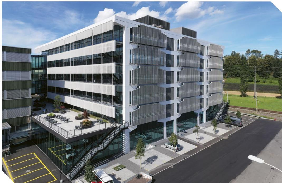
die natürliche Belüftung über die Aussenfassade an. Die Gitter an der Fassade des Neubaus verhindern während der Sommermonate eine zu starke Sonneneinstrahlung, lassen aber dennoch stets genügend Tageslicht herein. All diese Lösungen kommen ohne viel Technik aus und kennzeichnen modernste Industriearchitektur.
