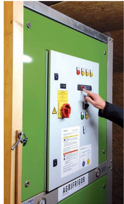
14 Wärmepumpe (Entfeuchter), Werksbild FrigorTec
