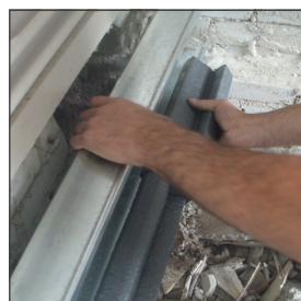
Aanbrengen thermostrip haakbeugel
