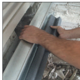
Aanbrengen thermostrip haakbeugel
