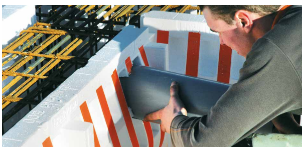
5 Eventuele sparingen maken en zijwanden plaatsen.
