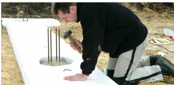
3 Met bodemplaten verbindingen maken tussen de hoeken.
