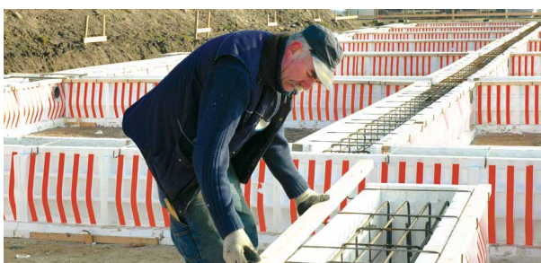
7 Houten ribben (afm. 50 x 70 mm) in bovenbeugels leggen en klampen bij hoeken.
