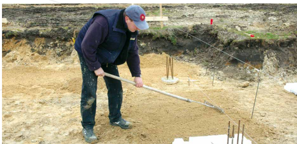
1 Het zandbed zodanig egaliseren en verdichten dat de bodemplaten voldoende ondersteuning krijgen.
