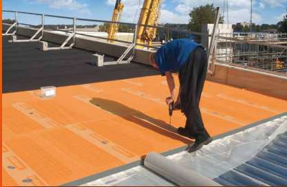
plat dak isolatie
