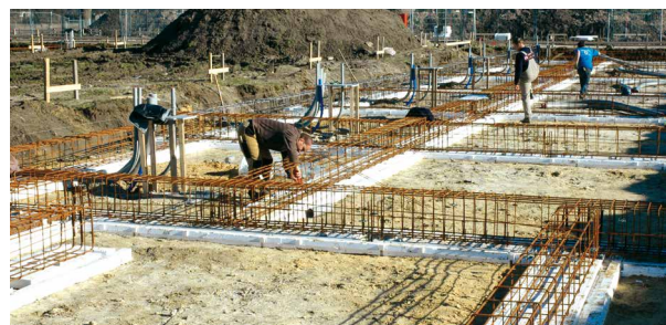
4 Wapening plaatsen en afstandhouders aanbrengen die voldoende betondekking geven en geschikt zijn voor isolatie op zachte ondergrond.
