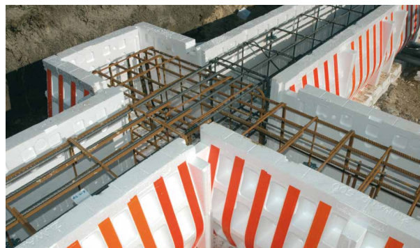
Eenvoudige realisatie van afwijkende vormen
