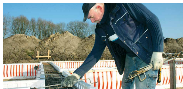
6 Bovenbeugels aanbrengen, ca. 600 mm h.o.h.
