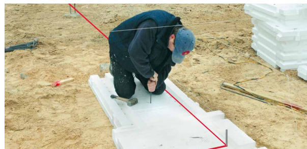
2 De bodemplaat kan dankzij de geïntegreerde voorziening over de vooraf uitgezette metalen piket geplaatst worden. Zo staat de funderingskist direct op de betonmaat uitgelijnd.
