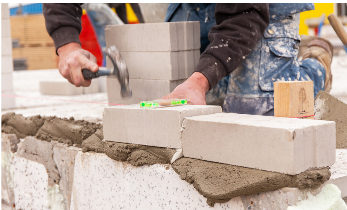
Kimblokken vlak in de specie plaatsen
