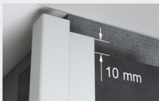
Laat de Hardie™ Plank MetalTrim™ sierlijsten boven- en onderaan 10 mm uitsteken.
