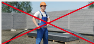
De Hardie® VL Plank platen worden in elkaar geschoven geleverd. Wanneer u de panelen wegneemt, moet u ze eerst zijwaarts wegtrekken en daarna pas optillen.
