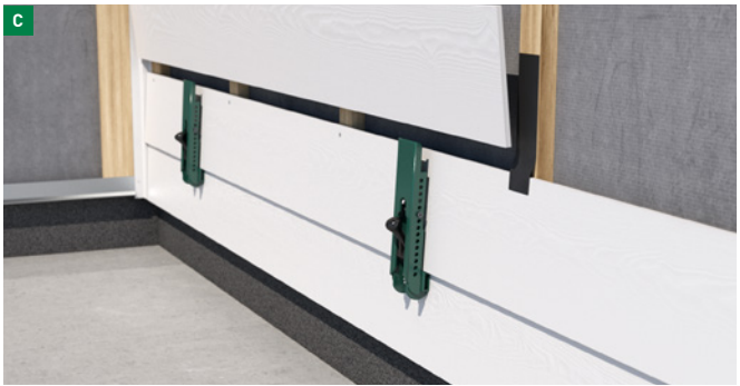
C: Volgende Hardie® Plank gevelbekleding erop zetten
