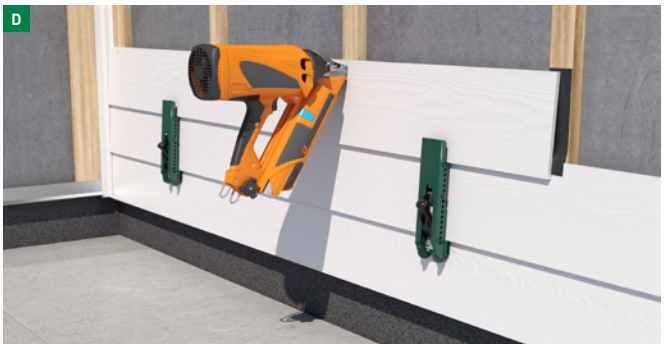
D: Vastschieten of -schroeven (voorboren niet nodig).
