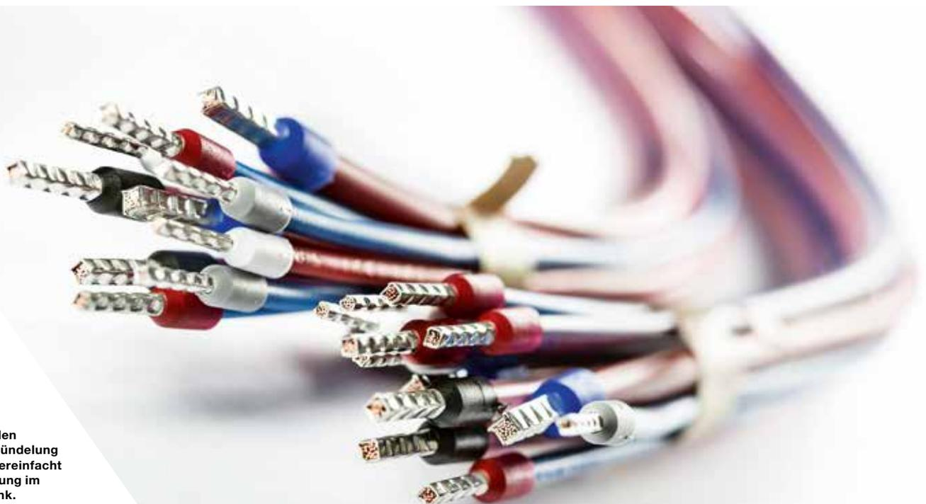
► Nach Bauteilen orientierte Bündelung der Drähte vereinfacht die Verdrahtung im Schaltschrank.
