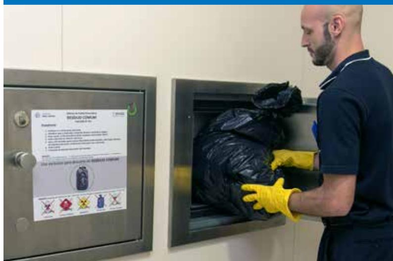
A partir de 2017, o recolhimento de resíduo hospitalar e roupas sujas no complexo hospitalar da Bela Vista passou a ser feito por transporte pneumático, um sistema de desenvolvimento recente em que não há contato com o resíduo e o risco de contaminação é reduzido. Utilizado para a coleta de resíduos sólidos, funciona por meio de um sistema de tubulações e recursos pneumáticos que percorre todo o hospital aspirando os sacos de lixo das áreas.
