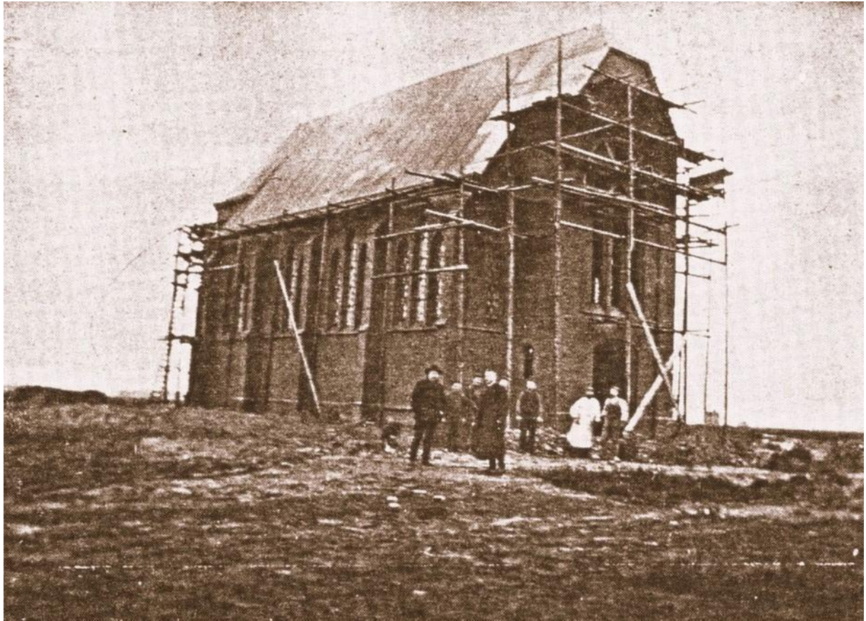
Gerardus Majellakerk in aanbouw
