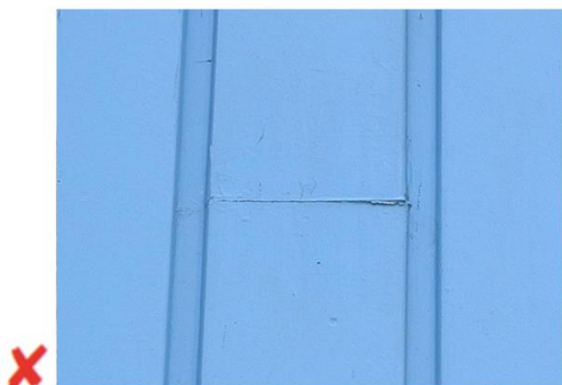
Afbeelding 8 - Stuiknaden fout gemonteerd (Bron: Centrum Hout, 2018)
