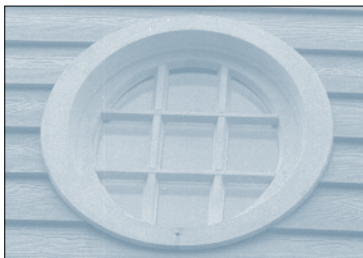
Afwerking rond raam met afdekprofiel.
