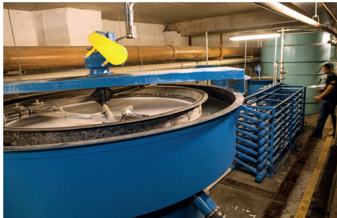
O engenheiro civil Luigi Ceolin na Estação de Tratamento de Água (à dir.) do hospital: economia no uso desse recurso
