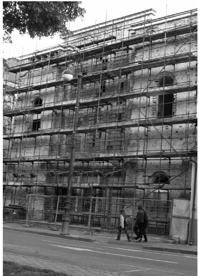
Pročelje sinagoge danas – u očekivanju nastavka radova na obnovi i rekonstrukciji
