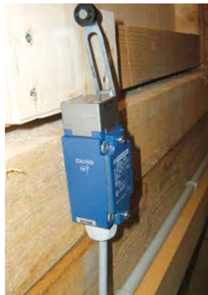
17 Endlagenschalter Luftklappe
