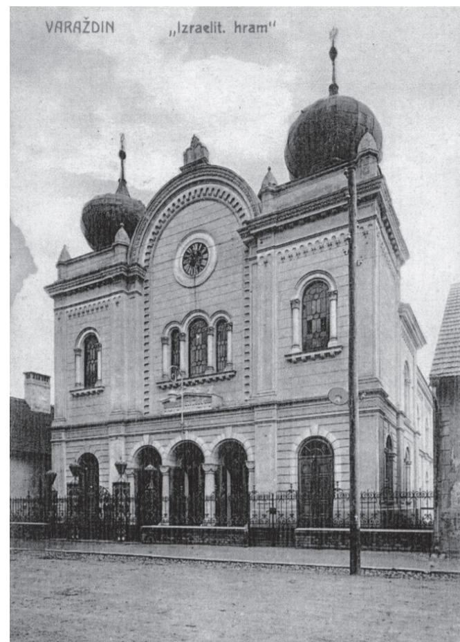
Prvotni izgled varaždinske sinagoge
