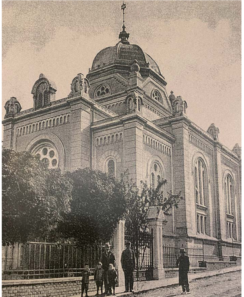
SINAGOGA U VUKOVARU, IZGRAĐENA 1889., DEVASTIRANA 1941., SRUŠENA 1958. (RAZGLEDNICA, 1897.) (ZK)
