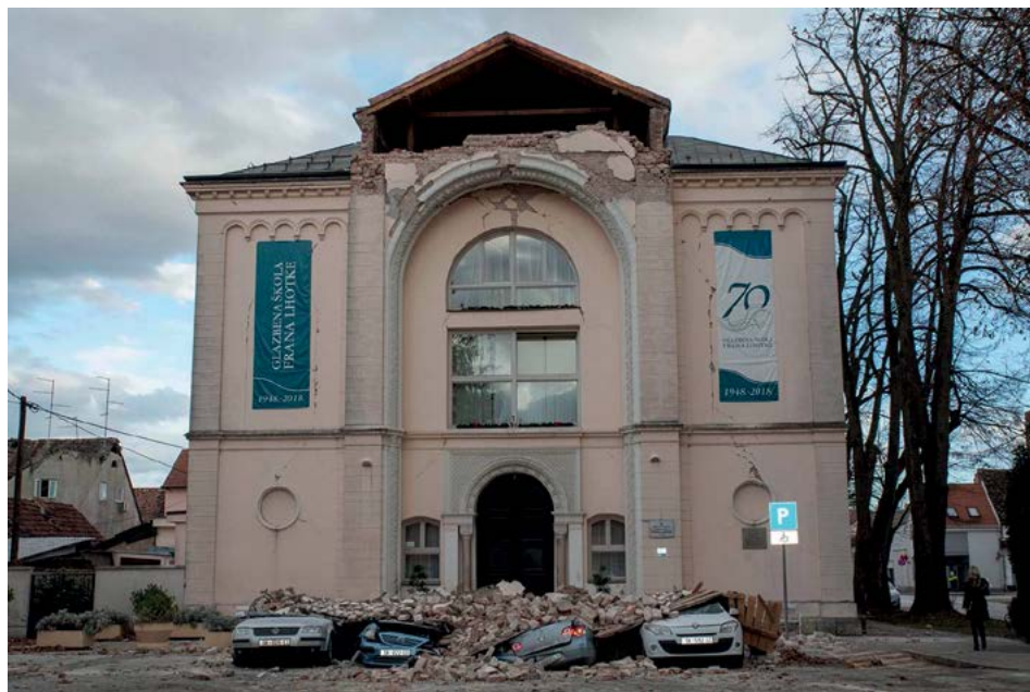
SISAČKA SINAGOGA NAKON POTRESA
