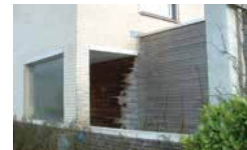
Foto 2: Voorbeeld van lelijke vergrijzing bij onbehandeld hout
