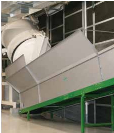
O CAMINHO DO LIXO Ao todo são 790 metros de dutos que conduzem resíduos não infectantes e roupas dos 112 pontos de descarte
