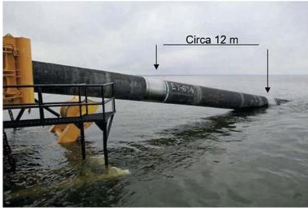
Figura 6: Posa di pipeline da pontone, con particolare della giunzione presente tra ogni modulo lungo 12 metri.
