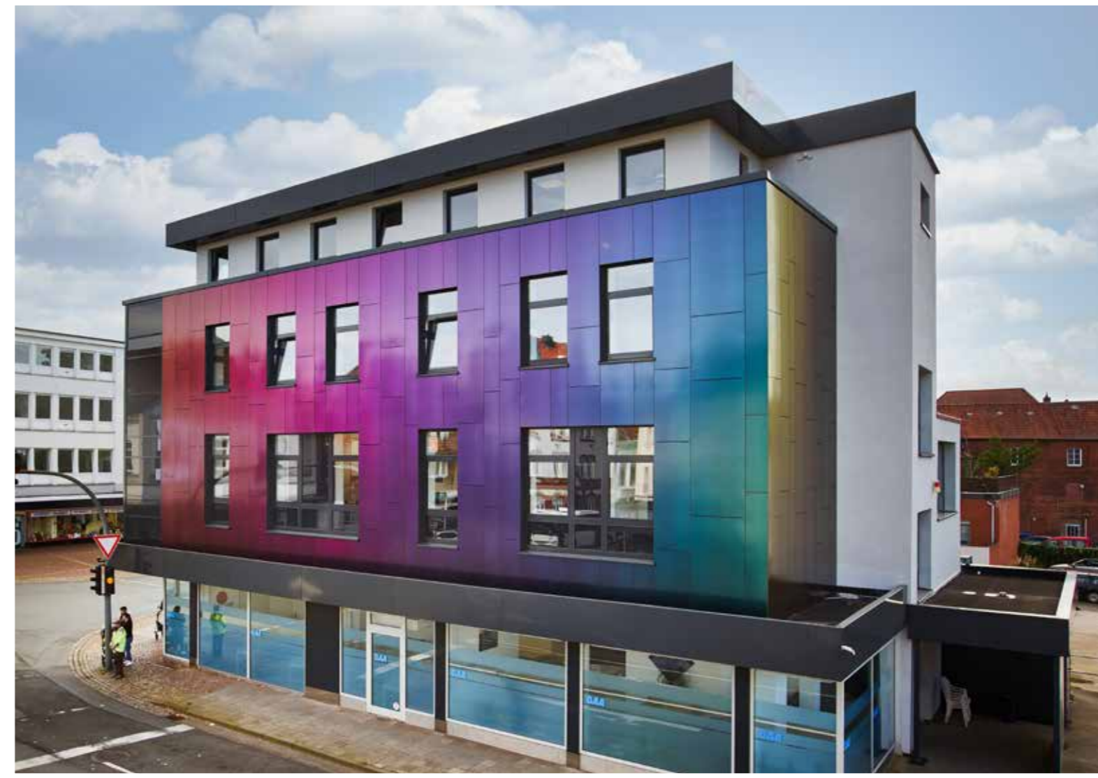
Project: Renovatie van kantoorgebouw, Nienburg, Duitsland
