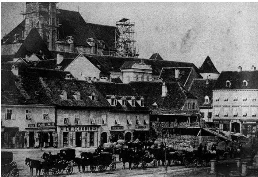
2. Dio sjeverne i istočne fronte sa starim kućama, nakon potresa 1880.
