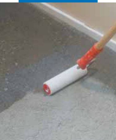
Het aanbrengen van Primer G met een rol
